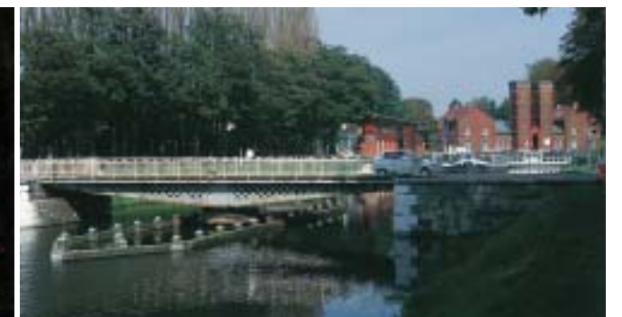
写真6 - 船舶の航行にあわせ回転する回転橋
