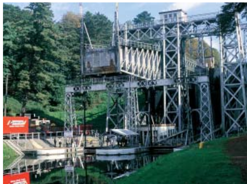
写真1 - ボートリフトNo.3とポンプ室
