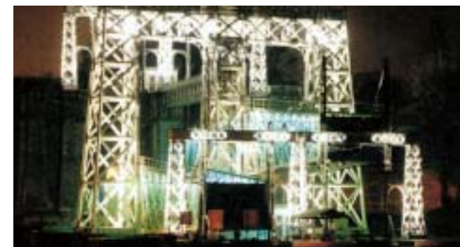
写真5 - ライトアップされたボートリフトNo.4
