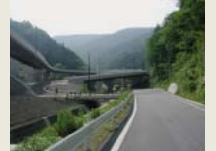
■写真1—現道から見たループ部
