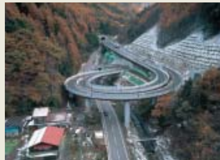
■写真3—神谷IC橋全景
