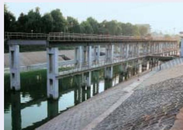
■写真7—船を台車に載せて引き上げる水上遊覧用の現在の閘門(通惠河)
