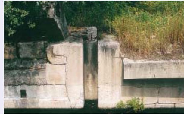
■写真5—水門を詰め込む石溝、その上方には水門を昇降させるための石条が見られる
