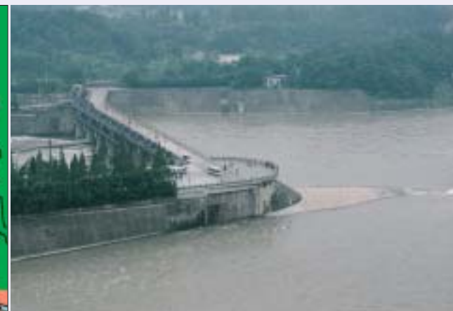
■図1—「都江堰」の流水コントロール模式図 ■写真2—岷江の流れを二分する「魚嘴」
