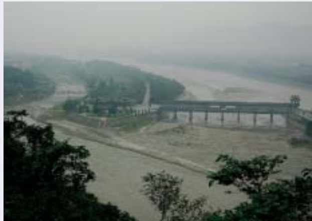
■写真5—余分な流水・土砂を本流に戻す「飛沙堰」
