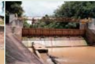
■写真14—④の水門
