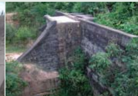
■写真12—②の水門(現在は壊れている)
