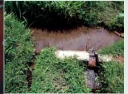
■写真10—溝の彫り幅によって個々の水田の水量を調整する量水堰 (木製)
