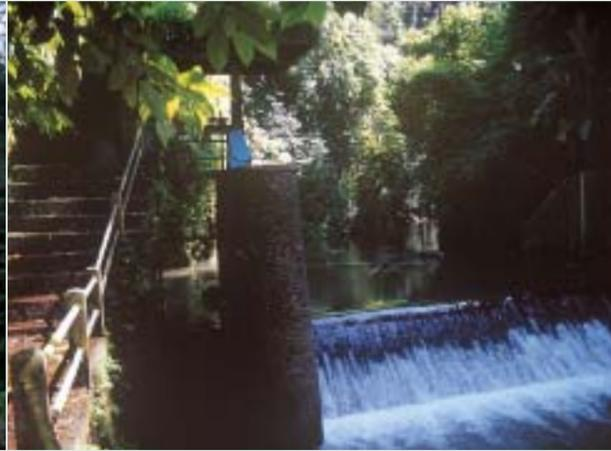
■写真5—トンネル水路に導水するための取水堰
