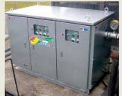
■写真3—超微細気泡散気装置
