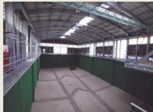
■写真7-最終処分場内部
