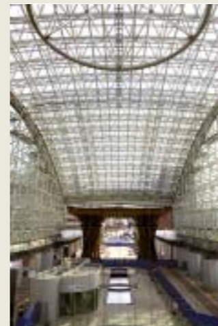
■写真9—大屋根内部(上部手前はテンションリング)
