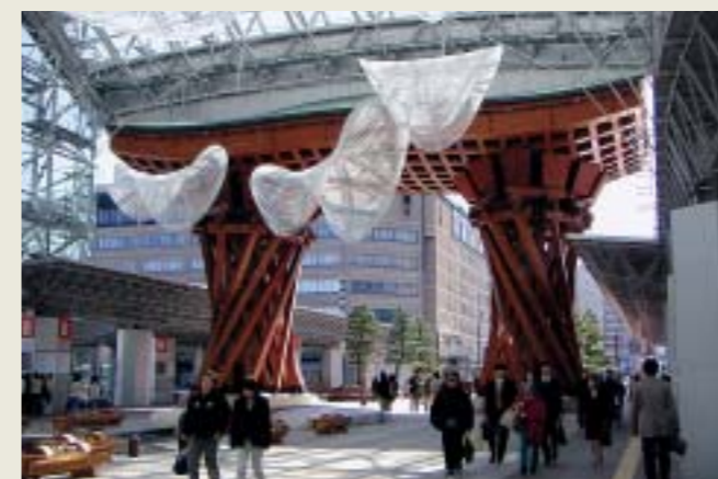
■写真3—大屋根内部から望むシティゲート
