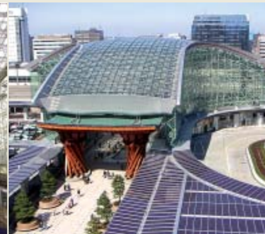
■写真10—大屋根(手前右は太陽電池を組み込んだ乗降場シェルター屋根)
