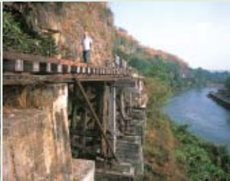
■写真6—アルヒル栈道橋 タイ国鉄では毎日点検してから列車を走らせているようだ
