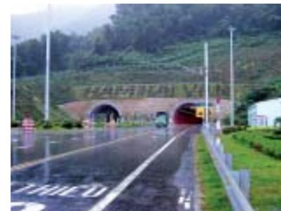
■写真2—豪雨に震むフエ側のトンネル坑口 左が避難坑 (写真：塚本敏行)
