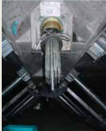
写真2-桁内ブレース(斜材定着部)
