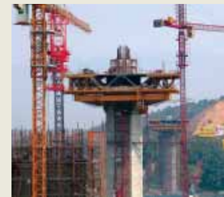
写真3-柱頭部主桁形状
