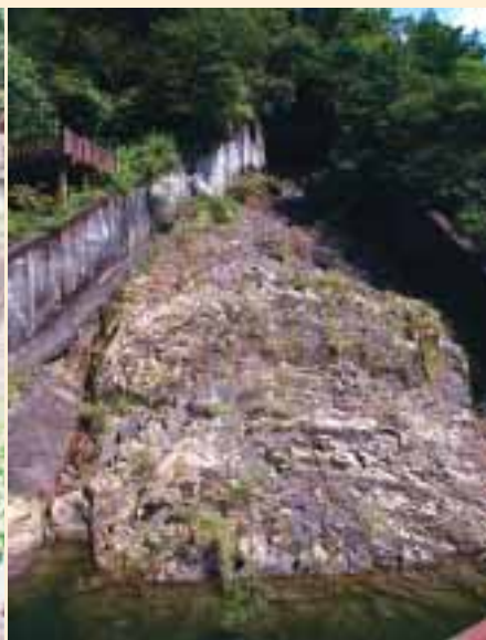
■写真5—余水吐口(外側)
