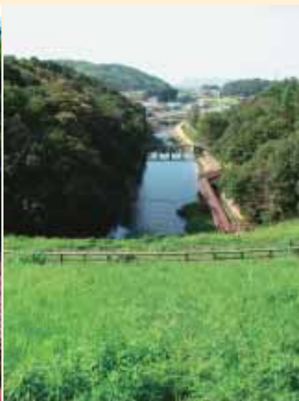
■写真6—土堰堤より用水路を望む
