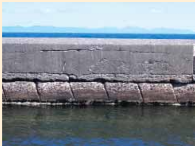
写真3—ブロックを斜め積みにした北防波堤
