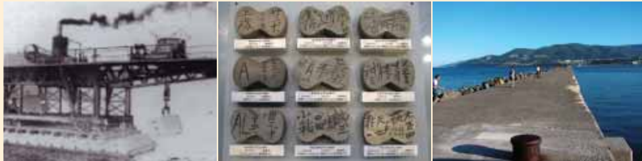
■写真5—ブロック据え付けに活躍した英国製積置機「タイタン」■写真6—モルタルブリケット
