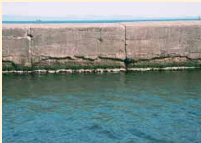
■写真8—ケーソンにより築造された島防波堤
