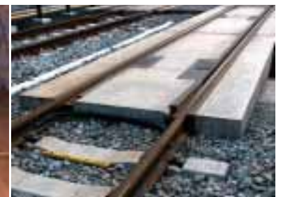
■写真7—「奥田中学校前」駅付近の道路併用軌道と専用軌道の中継レール部(写真:塚本敏行)
