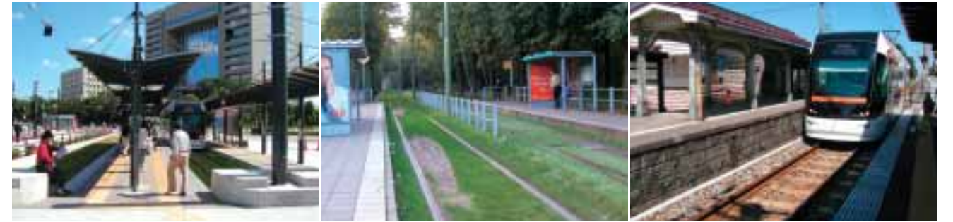
■写真2—起終点である「富山駅北」駅と芝生軌道(写真:米岡威)
