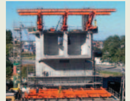
■写真1-P2柱頭部
