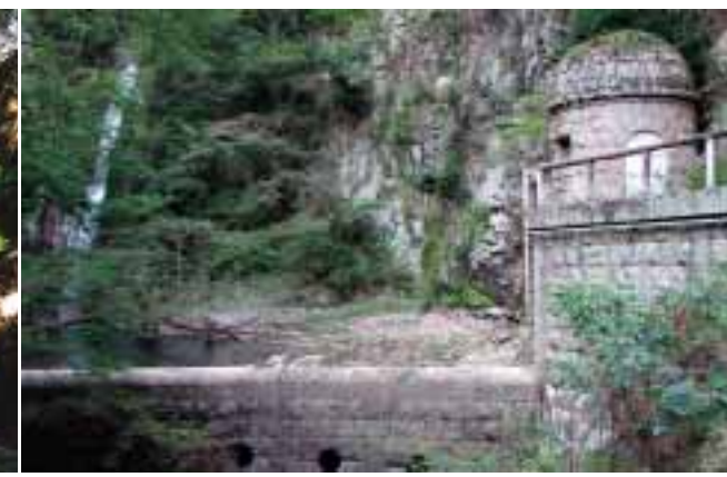
写真4—雌滝取水堰堤・取水井(国の重要文化財)
