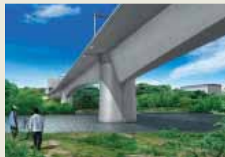
■図4—3径間連続PRCラーメン箱桁橋(CG)
