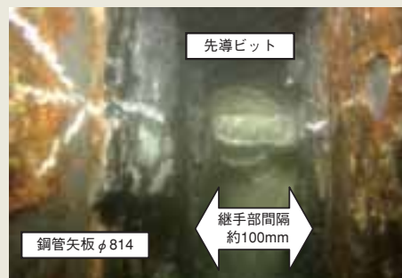
■写真2 到達精度確認状況(鋼管矢板継手部)
