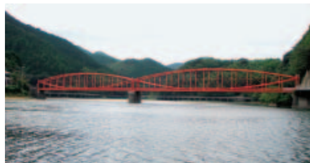
■写真1—横から見たシルエット。この形状から建設当初は魚形橋と呼ばれていた
