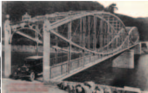
■写真11—自動車も通行する道路橋として利用されていたが、現在、自動車は通行禁止
