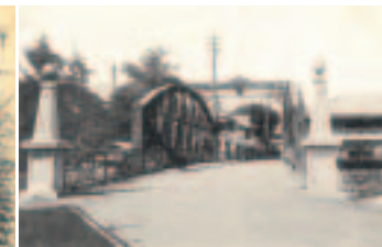
■写真4—1径間の桐生橋。桐生市十五年誌によると魚形トラスと記録されている。川の暗渠化にともない撤去
