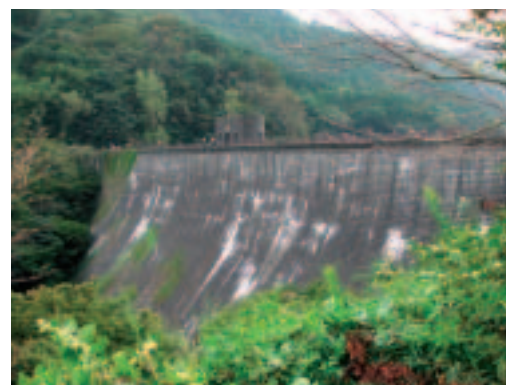
■写真5—河内堰堤。堰堤中央部に取水塔が見える。着工時にはアジア最大の規模であった
