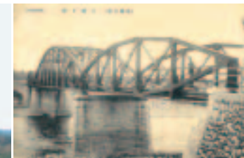
■写真3—中央と両端で長さの違う3径間の大渡橋。1935年に流失。架設工事概要によると、中央がプラットトラス、両端がパウリトラスと記録されている
