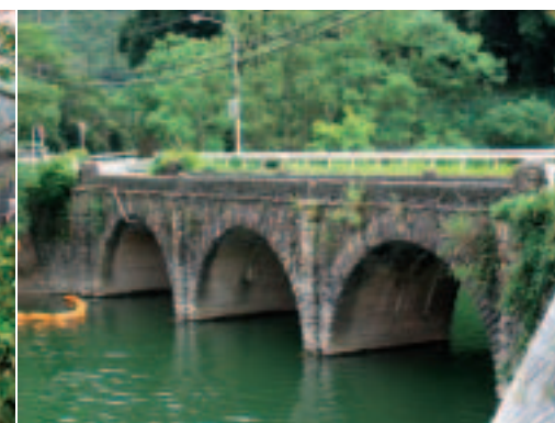
■写真6—中河内橋。建設当初はこちらが眼鏡橋と呼ばれていた。現在は拡幅のため反対側に橋が建造されている
