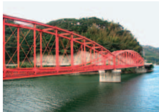
■写真2—緩やかな弧を描く部材が美しい。橋脚部は堰堤同様に切石積みコンクリートで土木施設群の一部であることを主張しているようだ
