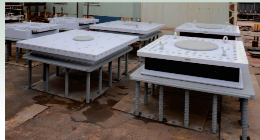
写真3 支承仮組状況(左:端橋脚可動脊、中:中間橋脚鉛直脊、右:中間橋脚水平脊)
