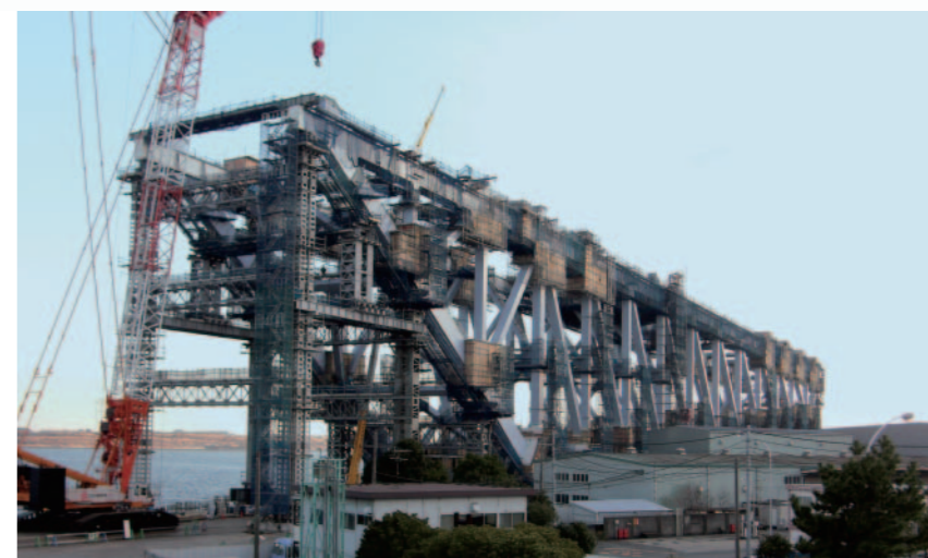
写真1 上部工組立状況
