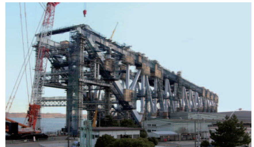
写真1 上部工組立状況
