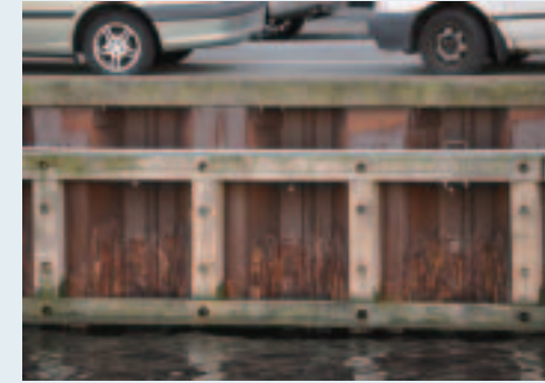
写真5 木材を用いた護岸
