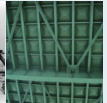
写真3 湿気抜きの小穴があるバックルプレート
