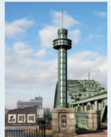
写真4 復元された親柱の飾塔
