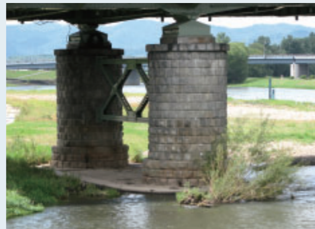
写真7 花崗岩を施した橋脚
