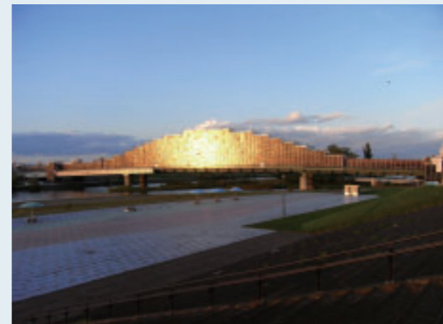
写真11 塗装工事中のパネルに夕日が映る旭橋
