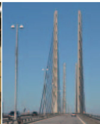
写真4 シンボルとなっている斜張橋
