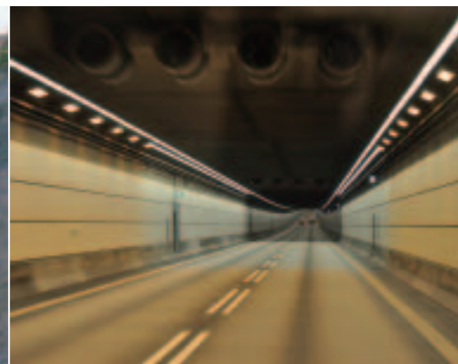
写真3 道路トンネルの内部
