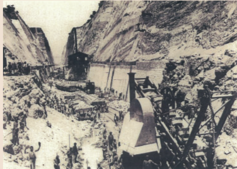
写真4 1887~1888年頃の建設中の写真
