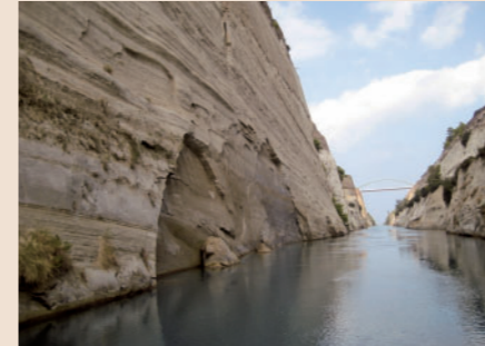
写真9 最近崩落したと思われる岩盤
