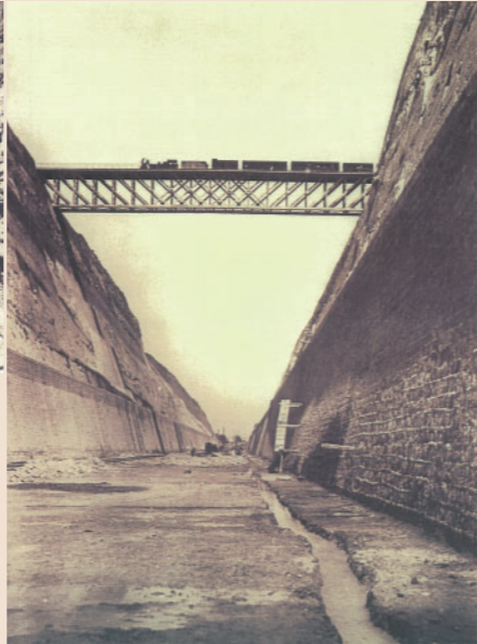
写真5 建設時、仮設の鉄道橋を渡る列車(1889年)
