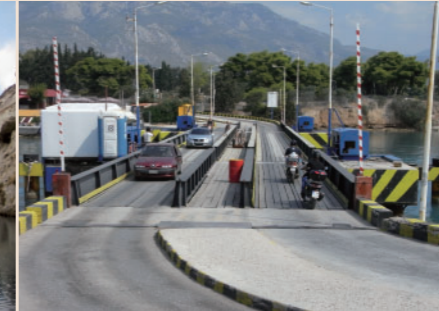
写真10 コリントス湾側の沈下式可動橋
