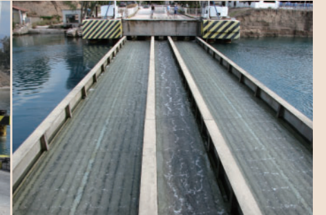
写真11 沈下中のサロニコス湾側にある可動橋
