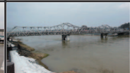
⑧(左) 1930年に架橋された下路カレンレバートラスとなる現在の大石田大橋 ⑨(下) 1901年に架橋された木橋の旧大石田大橋(1924年)
