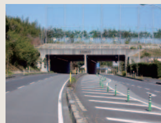
生目トンネル
