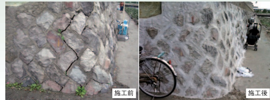
写真5, 6 既設護岸の目地補修
