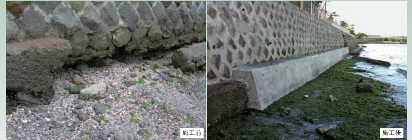
写真11, 12 石積み基礎・根固めの補修
