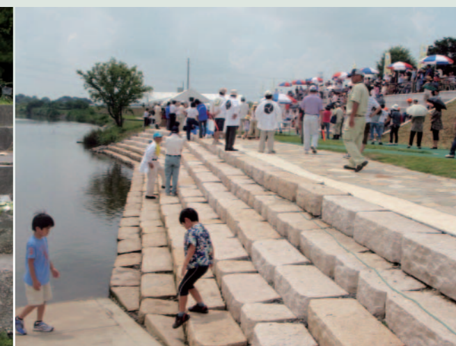
写真4 親水性のある自然石階段護岸の整備事例
