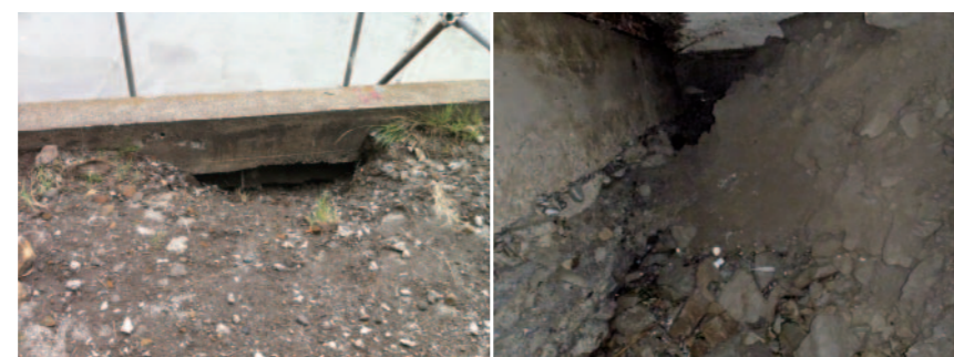
写真9, 10 試掘調査で判明した空洞部
