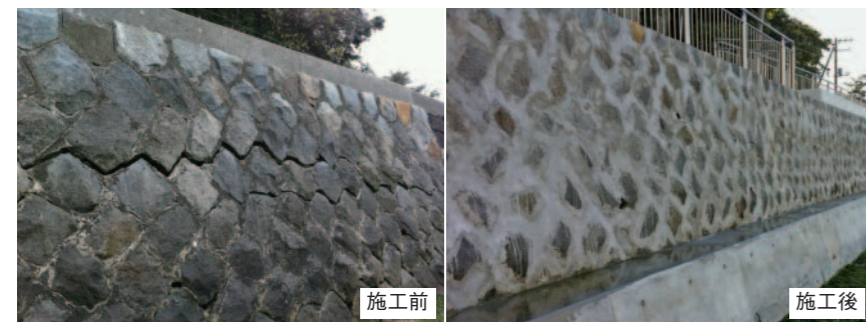
写真7, 8 既設護岸の目地補修
