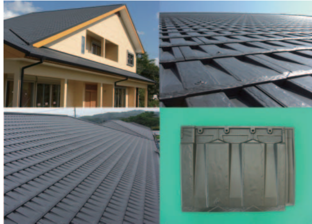
写真7 シラス大判瓦(右下)と屋根施工例
