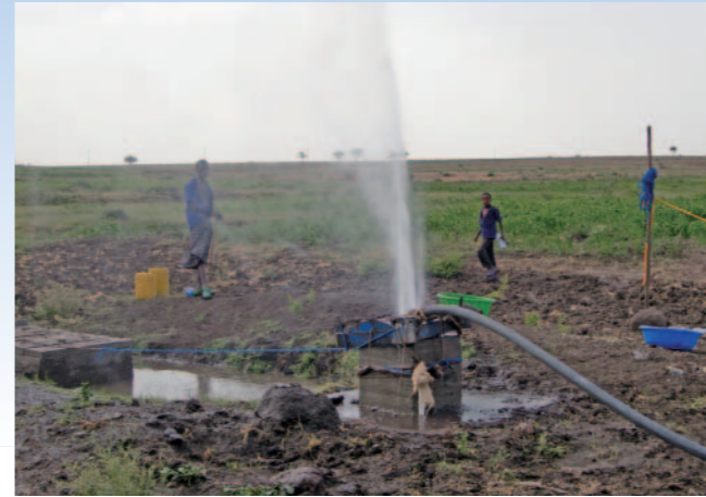
写真9 地下水開発現場
