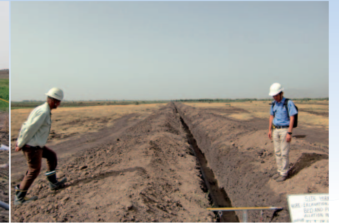
写真10 給水パイプ埋設現場
