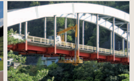
橋梁点検調査
