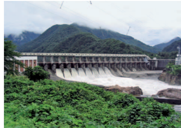
写真3 川幅いっぱいにゲートが設置されている鹿瀬ダム(新潟県・東北電力)
