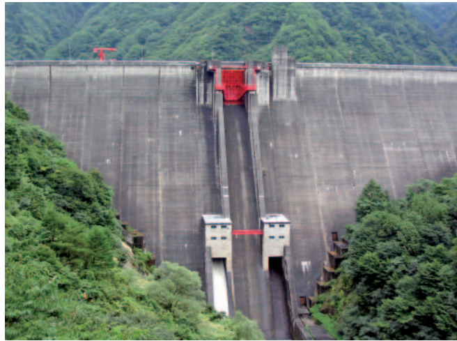
写真4 クレスト部にゲートを1門しか持たない加治川治水ダム(新潟県・新潟県)
