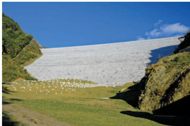
写真1 石を積み重ねて造られたダム。南相木ダムは日本一白いダムとして有名(長野県・東京電力)
