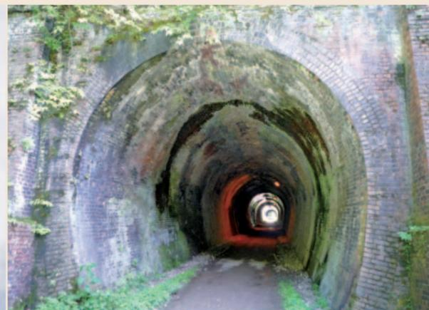
写真5 煉瓦の4号トンネル
