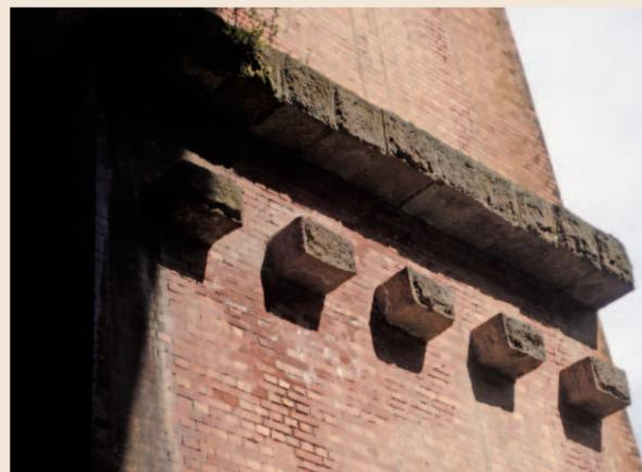
写真4 橋脚上部に残る石の突起部
