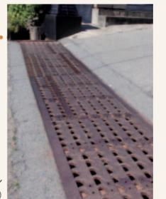
側溝の蓋として再利用されているラックレール
