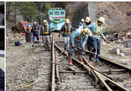
写真3 応急復旧工事の様子（田老駅付近 H23.3.23）
