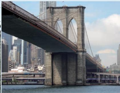
写真6 河床から24m掘り下げられたマンハッタン側の主塔
