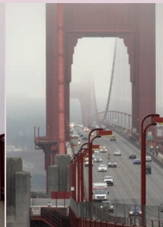
写真5 マリン郡から望む6車線の橋
