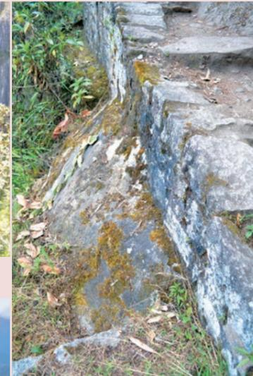
写真5 加工した石材を自然の山肌に積み上げたカパック・ニャンの基礎
