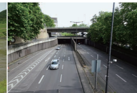
写真5 国道1号線の地下トンネル化の様子
