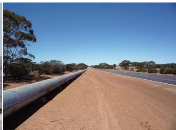
写真2 西オーストラリア州パースから金鉱の町カルグアリーに水を供給するパイプライン。道路と並行して走り、その長さは500kmを超える。ゴールドラッシュで集まった数万人の人口を維持するために1896～1903年に建設された
