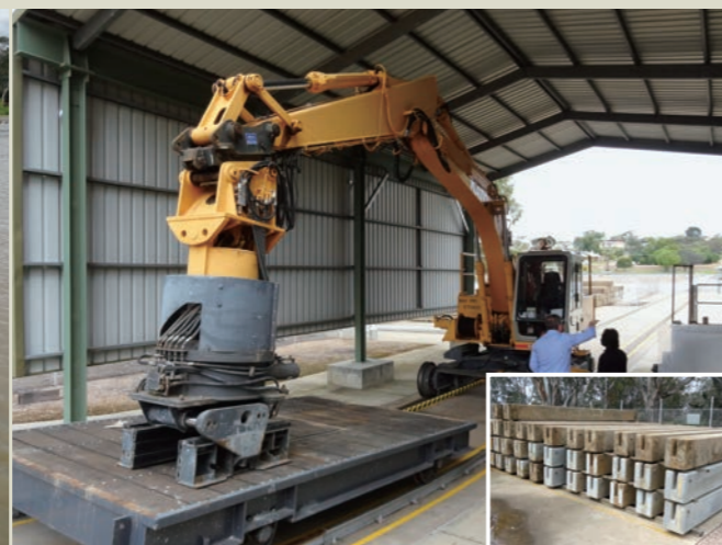
写真5 水位調整用堰板(右下)とその設置用重機
