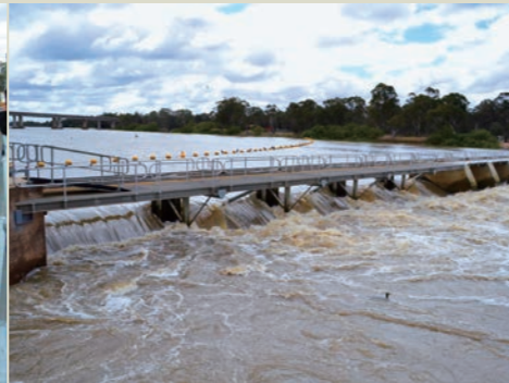
写真3 右岸側の取り外し可能な5連の堰
