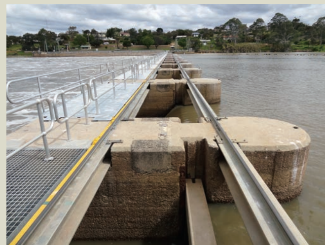
写真4 重機移動用のレールがある堰
