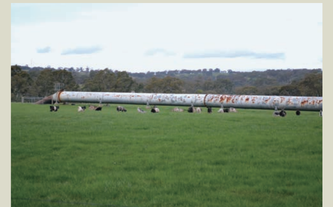
写真9 牧草地を通過するパイプライン
