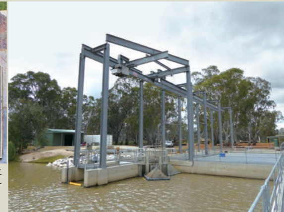
写真7 左岸側にある魚道施設
