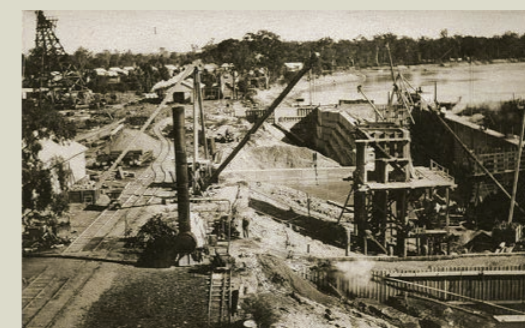
写真1 建設時のロック&ウィアー1号
