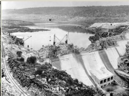
写真6 建設中のカタラクトダム
