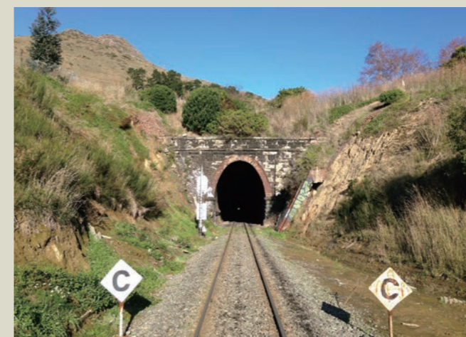
写真1 ヒースコート側の坑口
