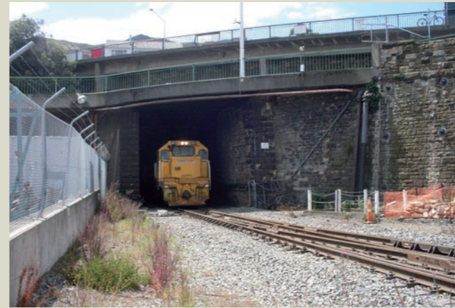
写真5 リトルトン港側の坑口
