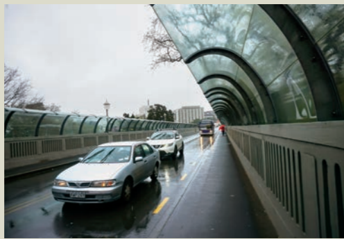
写真7 歩道の屋根と眺望性を兼ね備えた防護壁
