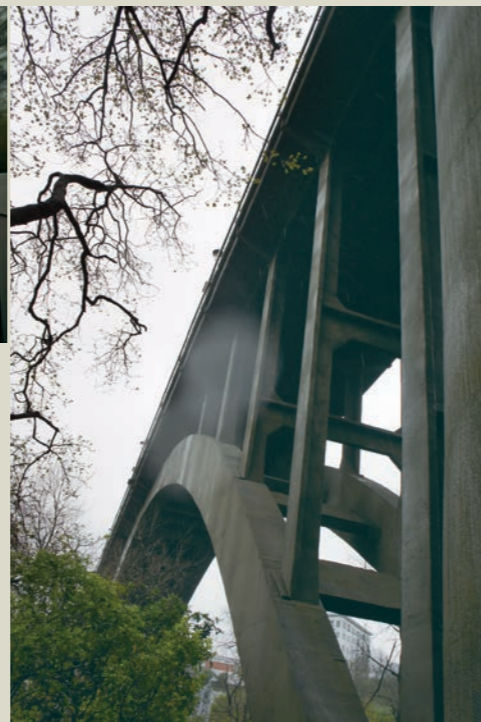
写真8 谷底より望む優雅な曲線を描くアーチ部
