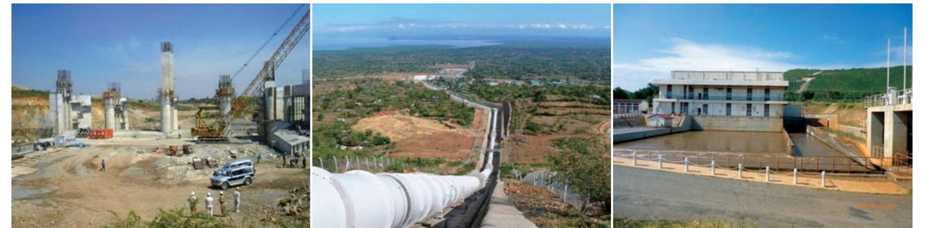
写真1 建設中の取水堰
