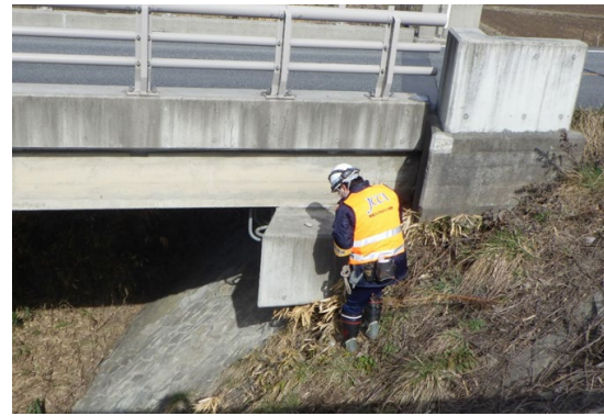
写真 5-2-4 橋脚の被災状況確認
