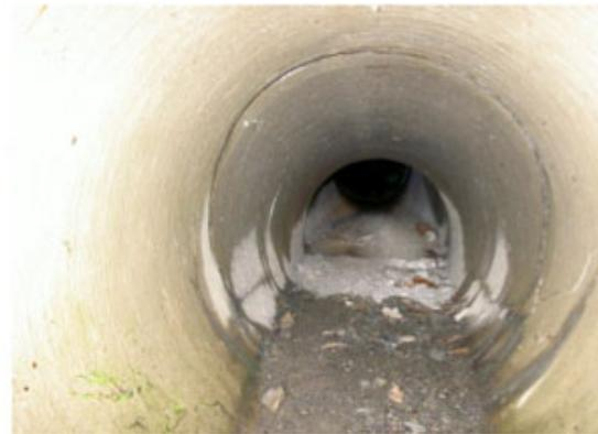
写真-2.1 新潟県中越地震による盛土崩落<sup>6)</sup> 写真-2.2 横断管の破損・土砂の堆積<sup>8)</sup>
