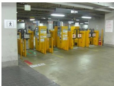
図-3 高松駅前広場地下自転車駐車場
