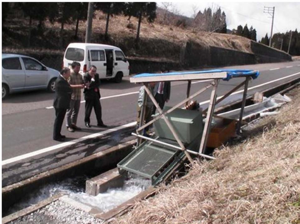
図 1 小水力発電の設置例
