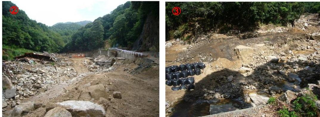
写真-4.2.8 天地川砂防堰堤被災状況
