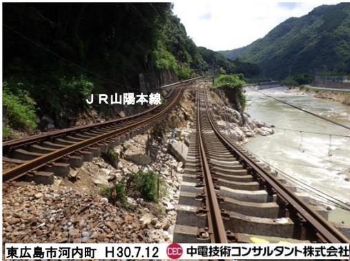
写真-5.4.3 J R 山陽本線軌道下土砂流出状況
