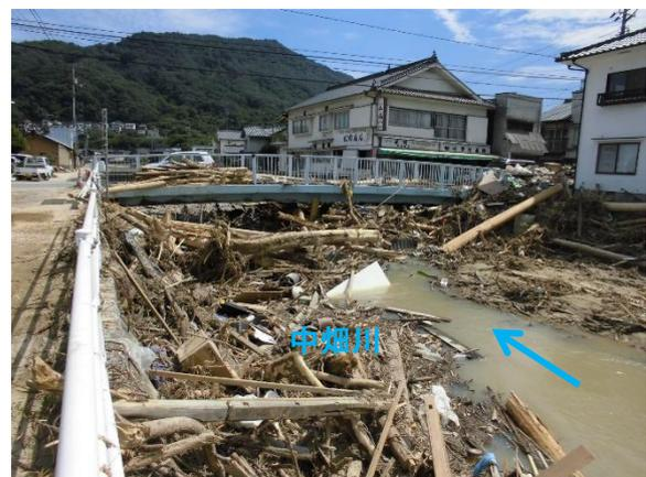
写真-5.2.8 流木による橋梁部閉塞（中畑川）
