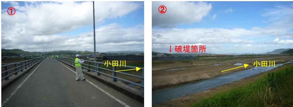
写真-4.2.3 小田川左岸（高馬川合流部下流）の破堤箇所及び河道整正の状況
