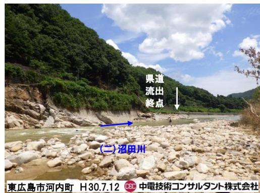
写真-5.4.6 下流側護岸も流出（対岸より撮影）
