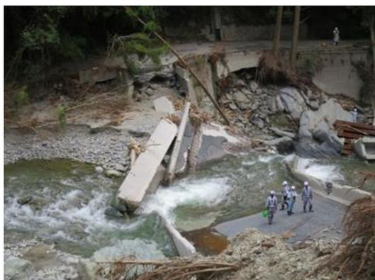
写真-3.3.1 立川橋上部工流失箇所調査
