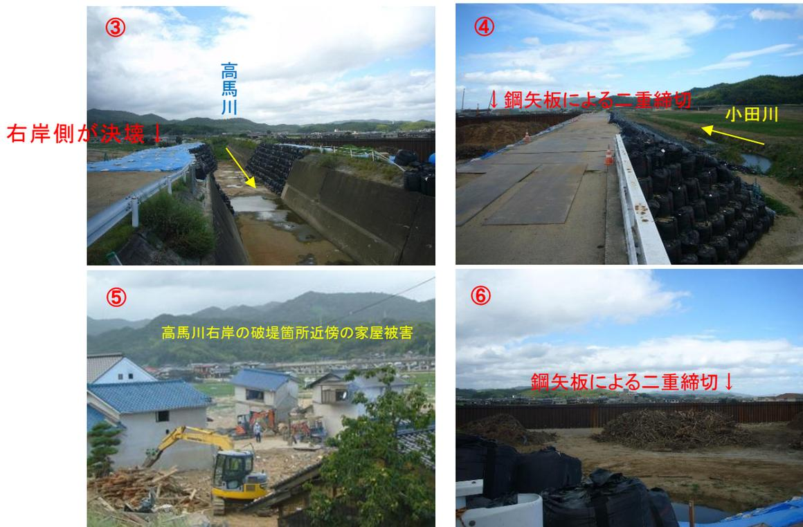
写真-4.2.4 小田川・高馬川合流部破堤箇所付近の状況
