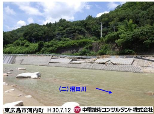
写真-5.4.4 上流側護岸は吸出しにより変形（対岸より撮影）
