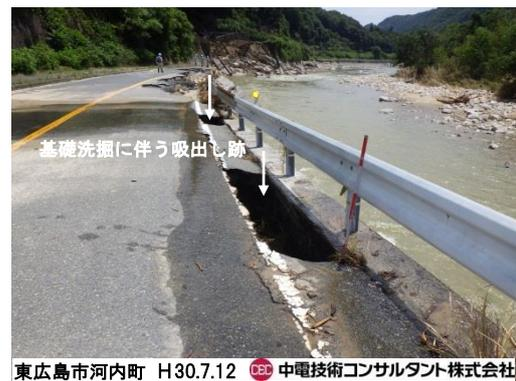
写真-5.4.2 兼用護岸背面土砂の吸出し状況
