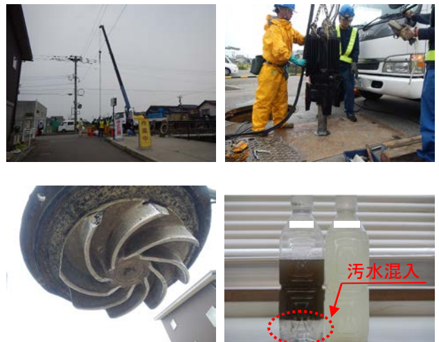
図-3 引上・点検時の状況
